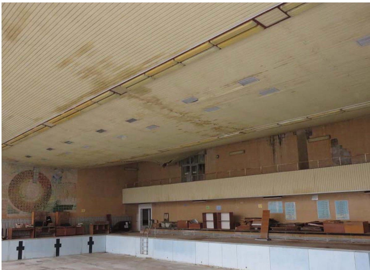
Budova plavárne – prevalený strop nad bazénom
