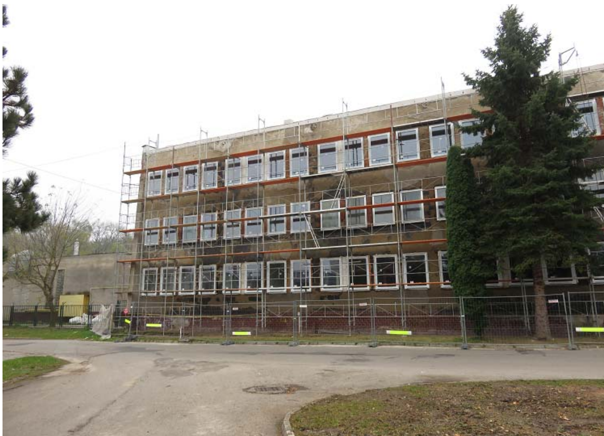
Budova plavárne – montáž obalových konštrukcií na prevlhnuté murivo
