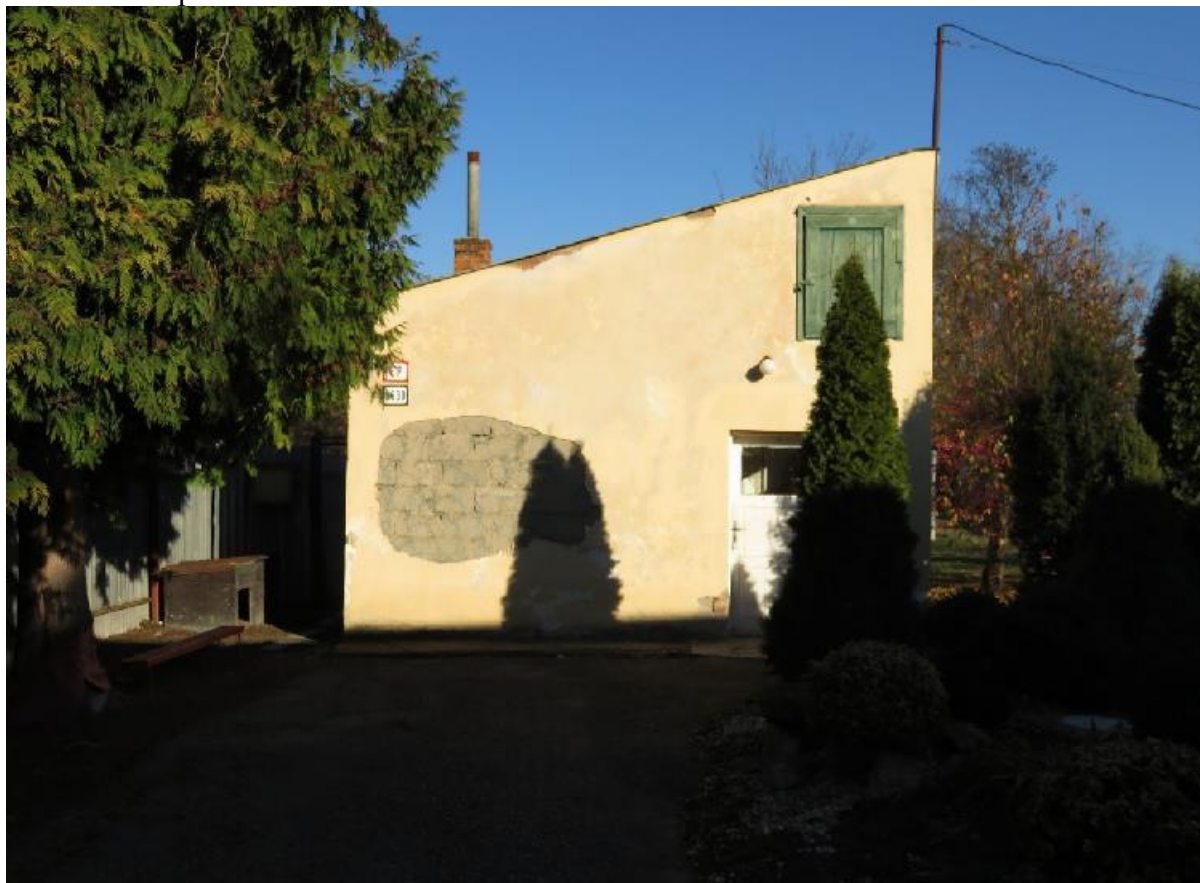
Budova manipulačného skladu
