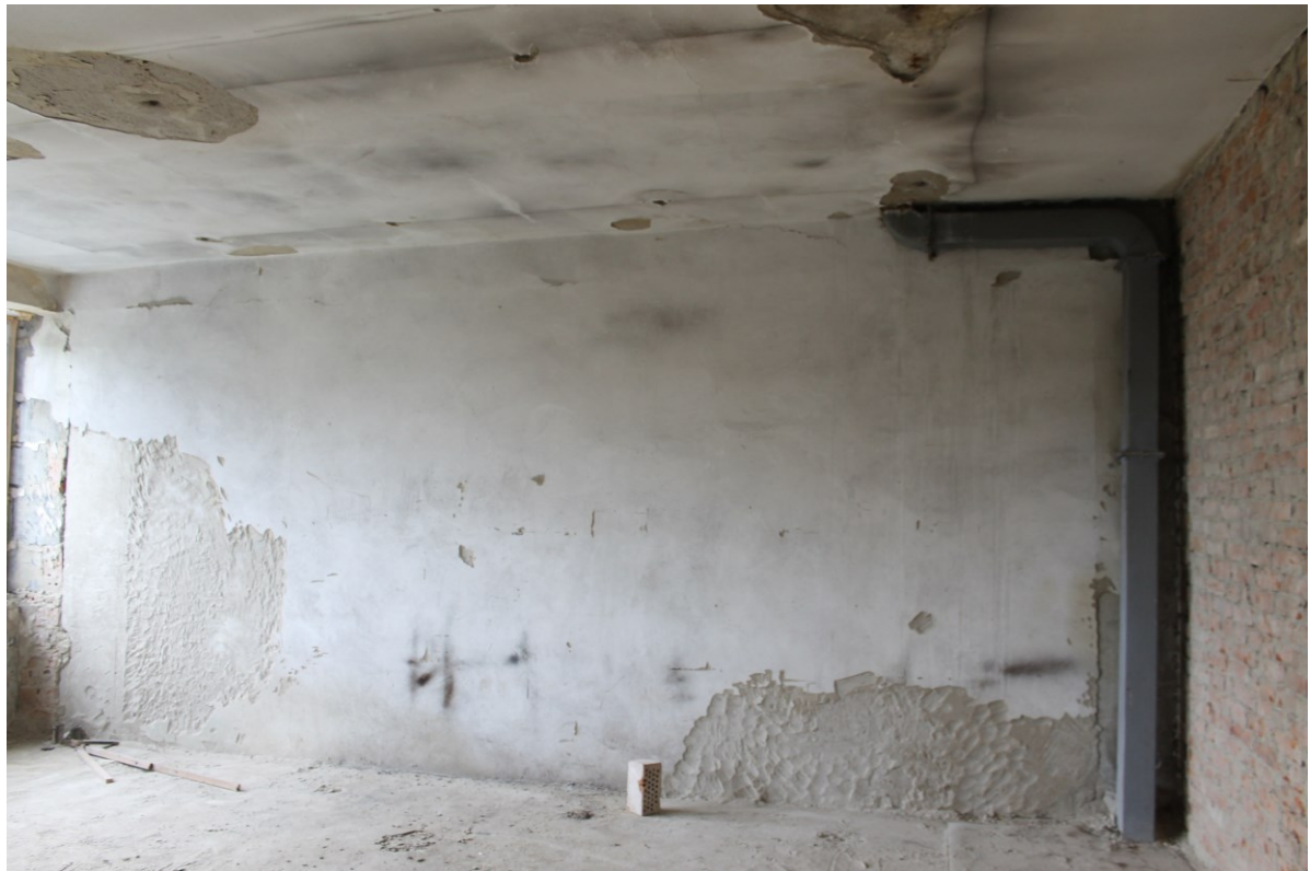
Obrázok 4 Stav po I. etape rekonštrukčných prác
