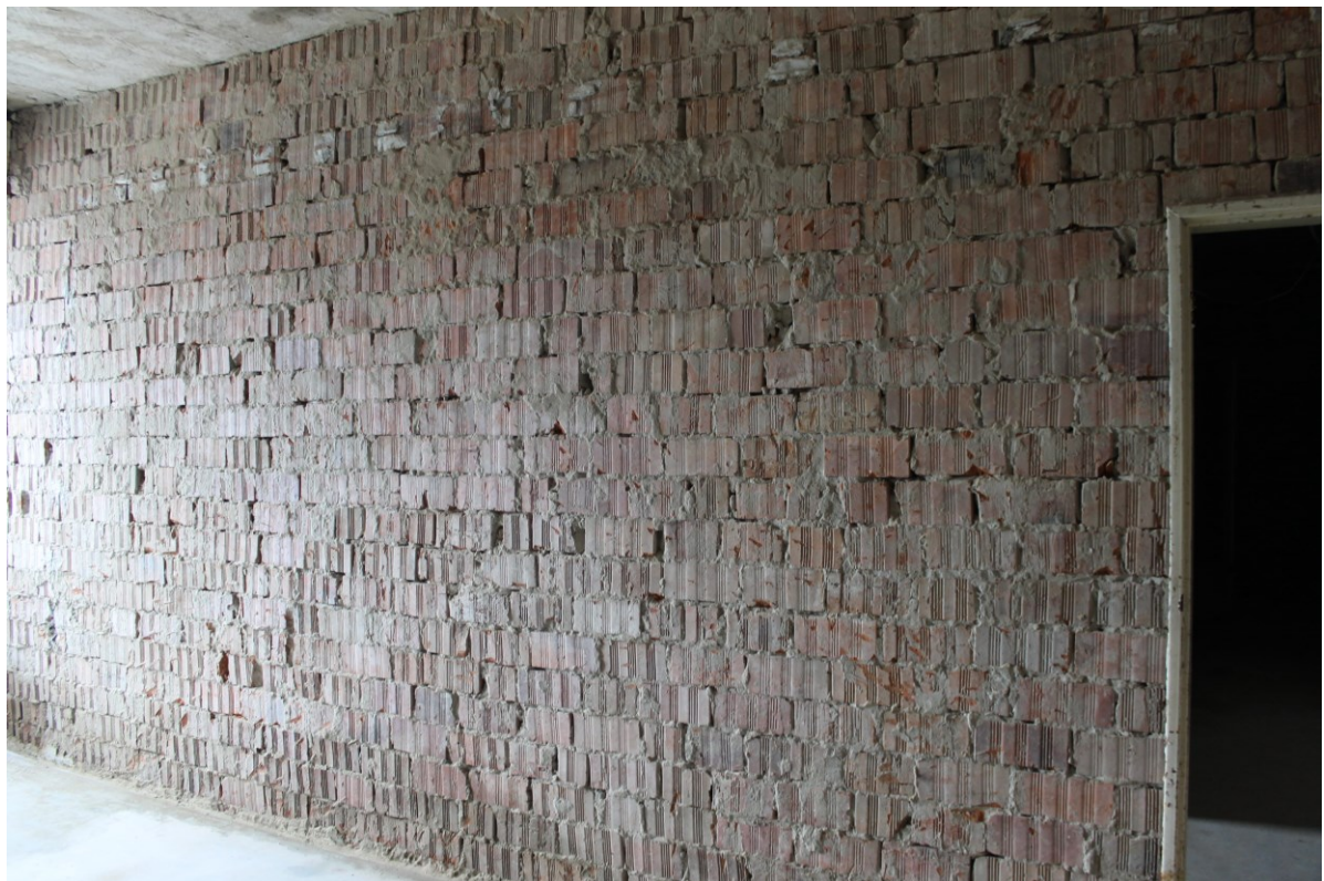
Obrázok 5 Stav po I. etape rekonštrukčných prác
