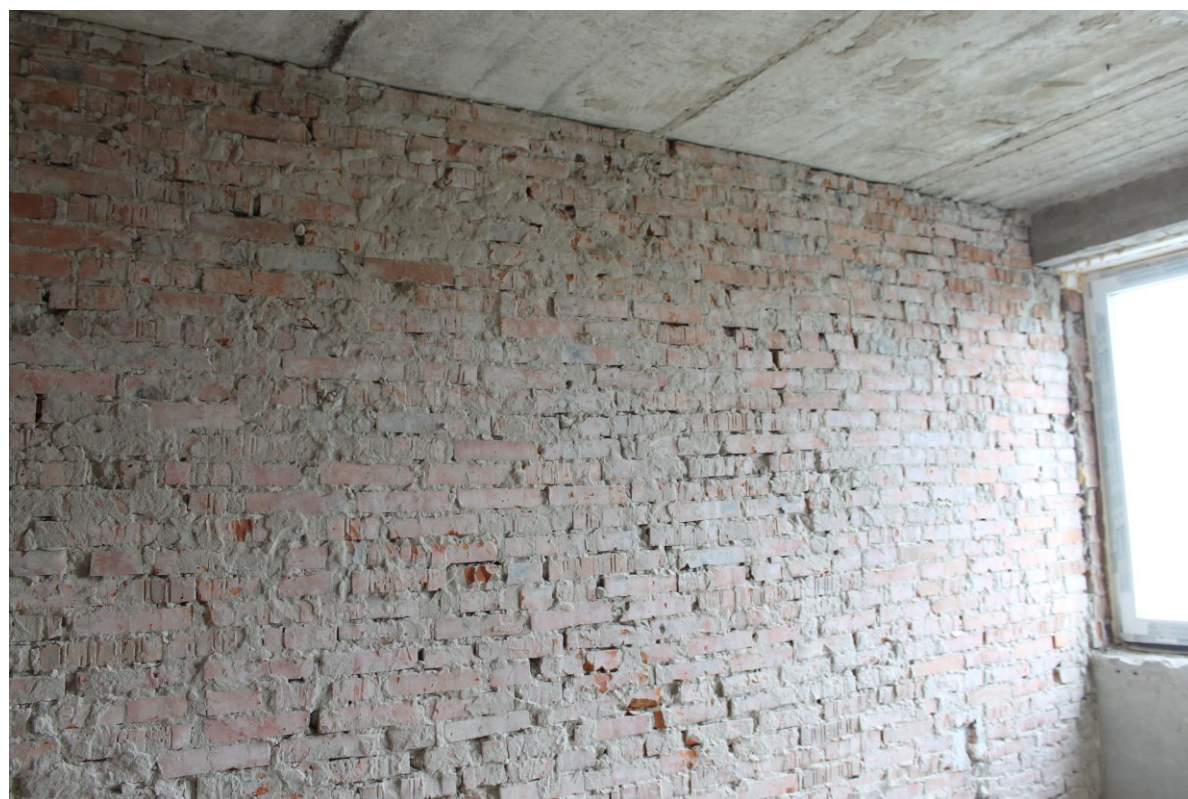
Obrázok 3 Stav po I. etape rekonštrukčných prác
