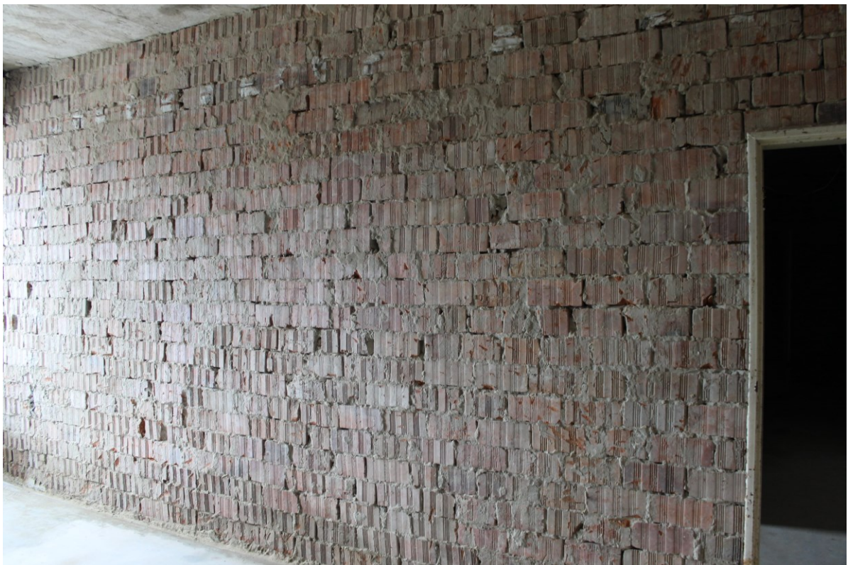
Obrázok 5 Stav po I. etape rekonštrukčných prác
