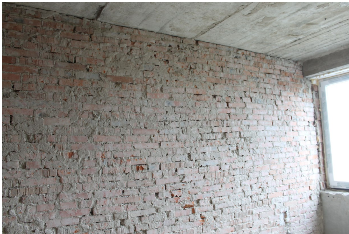
Obrázok 3 Stav po I. etape rekonštrukčných prác
