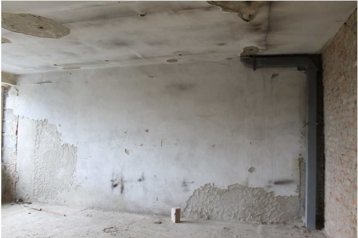
Obrázok 4 Stav po I. etape rekonštrukčných prác
