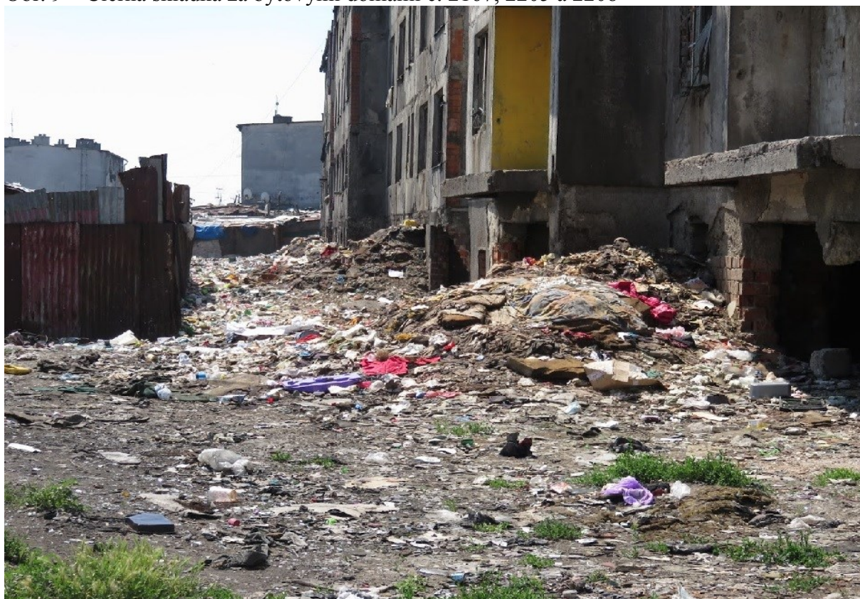
Obr. 9 – Čierna skládka za bytovými domami č. 2167, 2205 a 2208
