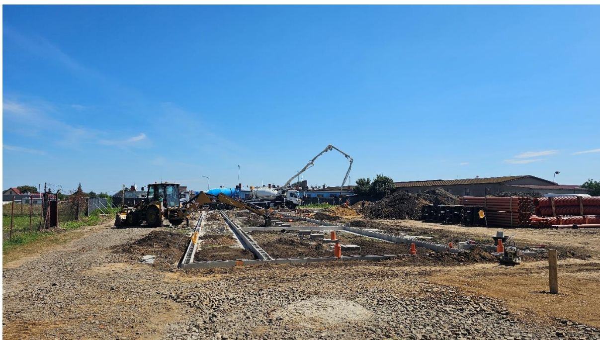
Betonáž základových konštrukcií
