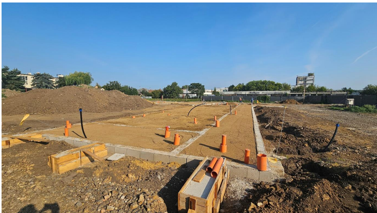
Ležaté rozvody a dokončovanie základových konštrukcií
