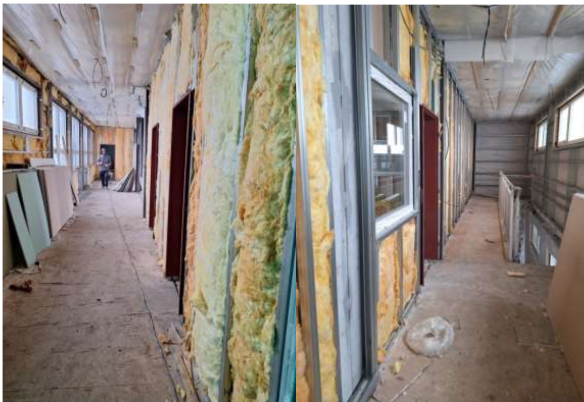
Práce na vnútorných konštrukciách
