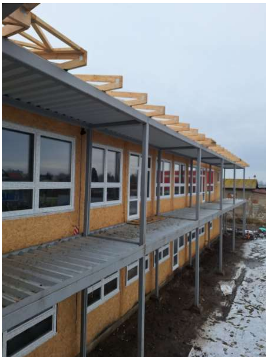
Pohľad na dokončovanie montáže krovu
