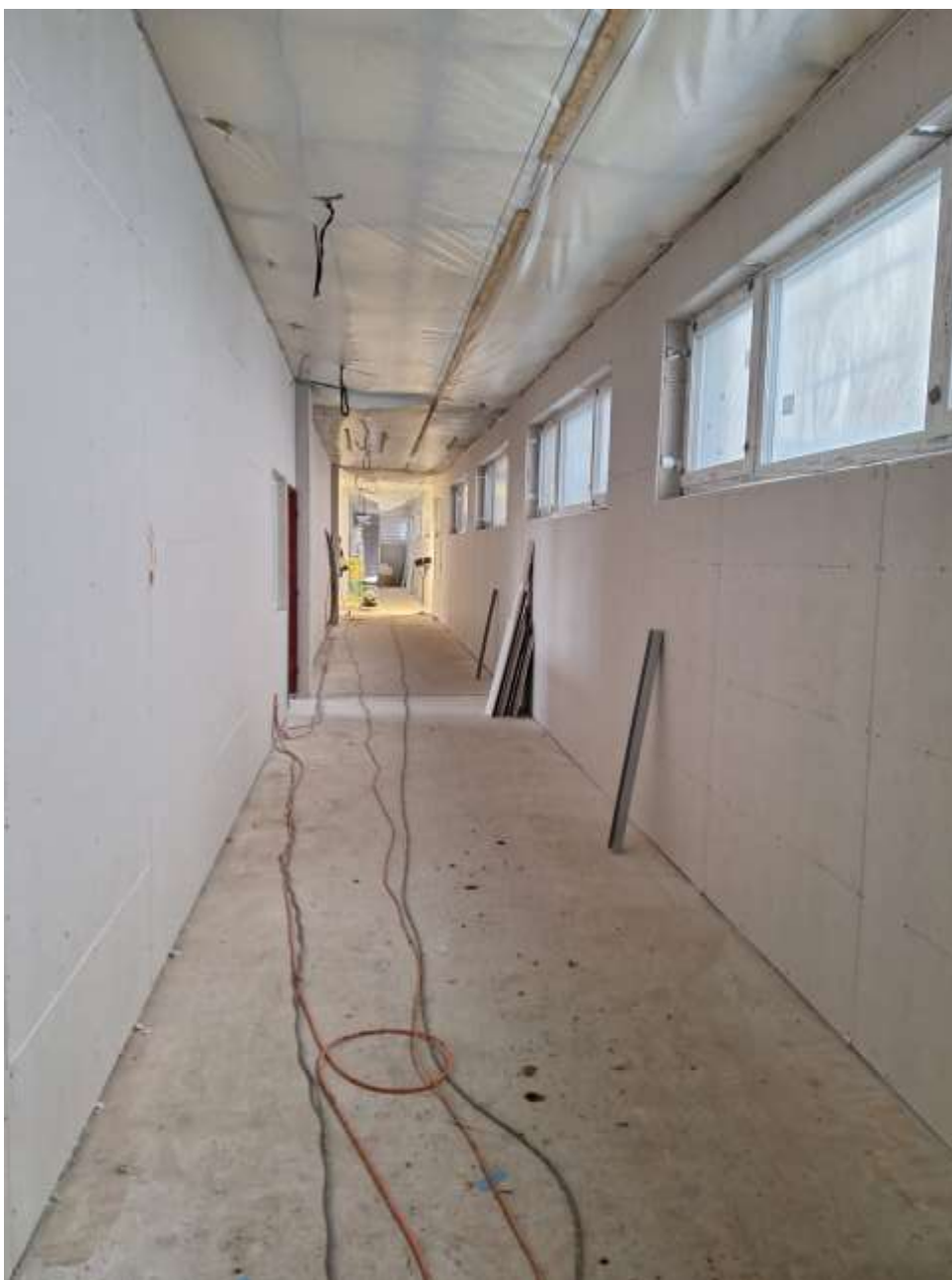
Ukončovanie sadrokartónových prác na chodbe
