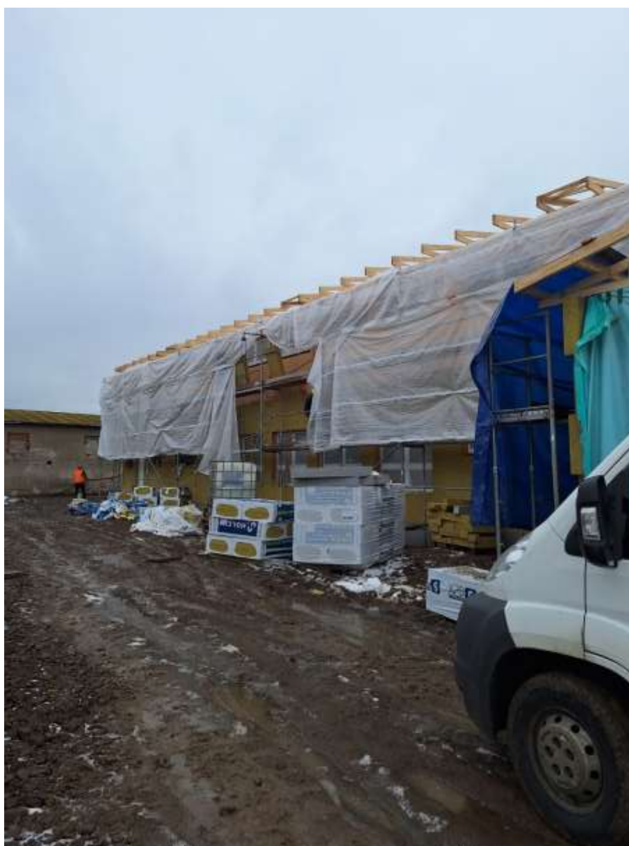
Realizácia zateplenia fasády zo severnej strany budovy
