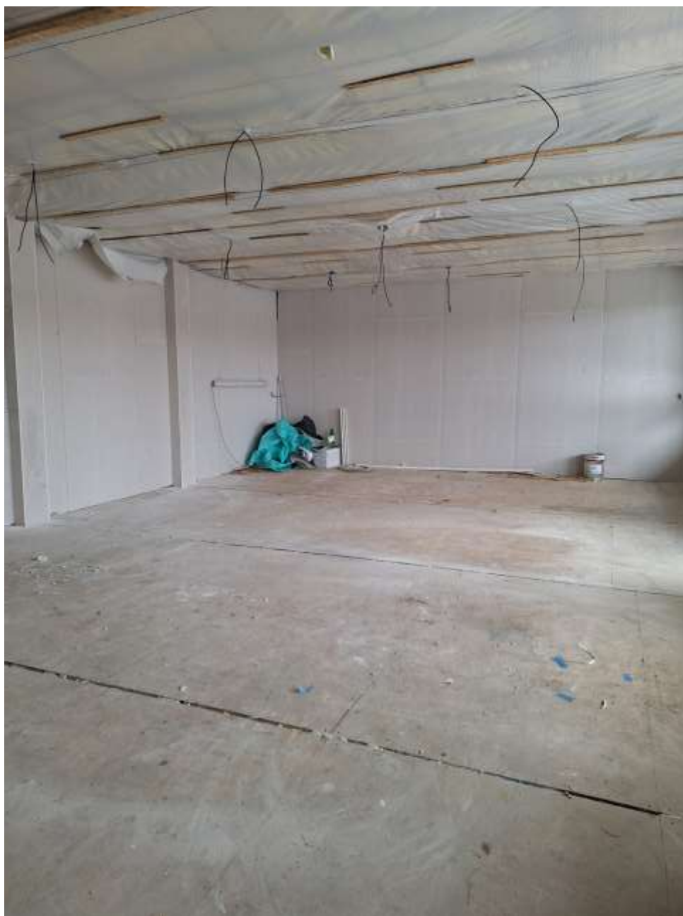
Ukončovanie sadrokartónových prác v jednej z učební
